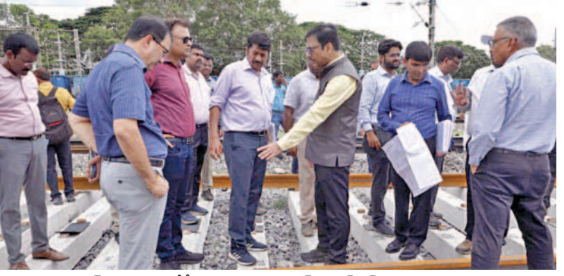
ట్రాక్ పనులను పరిశీలిస్తున్న జిఎం అరుణ్ కుమార్ జైన్ ఇతర అధికారులు
